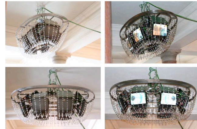
Gegenüberstellung vor (linke Seite) und nach (rechte Seite) Reinigung und Monitoraustausch. Die unterschiedliche Grösse der Platinen und die verschiedenen Neigungswinkel sind gut zu erkennen.
